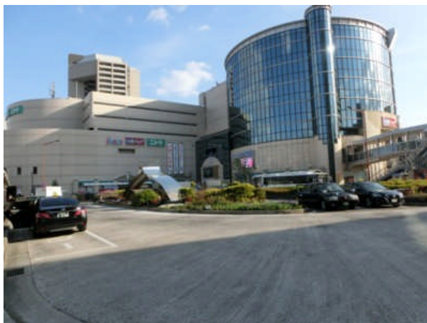
(写真左) 駅南側のバスターミナルです。 タクシー乗り場でもあります。 奥に商業施設もあります。
